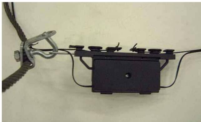
2. 引き込み金物に引留めリングを引掛け、支持線を弛ませないように張ります。家屋側のケーブルは現場に合わせて安全に配線します。
