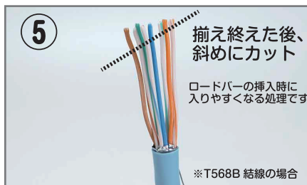
⑤ 点線のように斜めにカットします。 ※T568B 結線の場合
