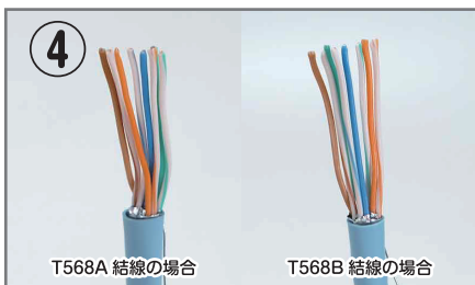
④ 各色のケーブルのよりを戻します。スパイクやドライバー等でケーブルのよりを戻し、配線の規格に従って順番に並べます。 ※上記「■結線表」をご確認ください。
