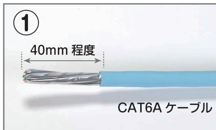
① ケーブルの外被を 40mm 程度取り除きます。その際、内部導体まで傷が付かない様に慎重に切断して下さい。
