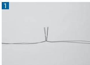
接続する心線を3回ひねり合わせ30mmの長さに切りそろえる。
