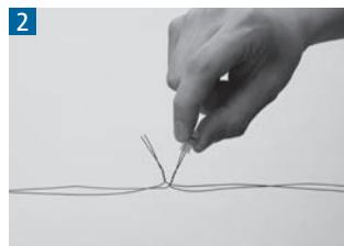
切りそろえた心線をUエレメントコネクタに挿入し、心線が十分に入っているかどうかを確認する。
